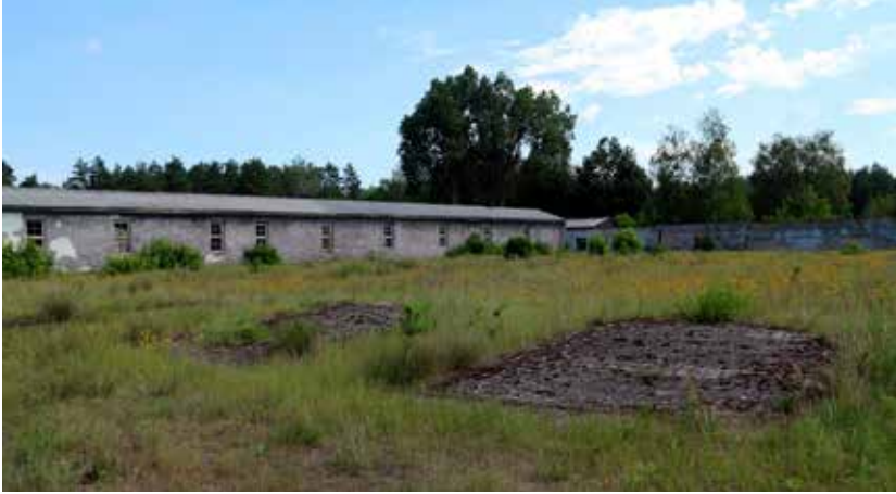
Baureste auf dem Männerlager (2019). Das Gebäude im Hintergrund gehörte bereits zum Frauenlager. Foto: U. Kasten.
